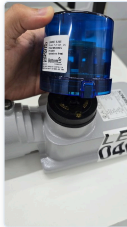
Encaixe do LUMiNET no soquete NEMA da luminária — gire até o final para garantir IP66
